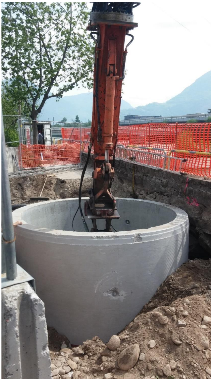
Figura 8-J : Scavo con rostro interno pozzo autoaffondante
