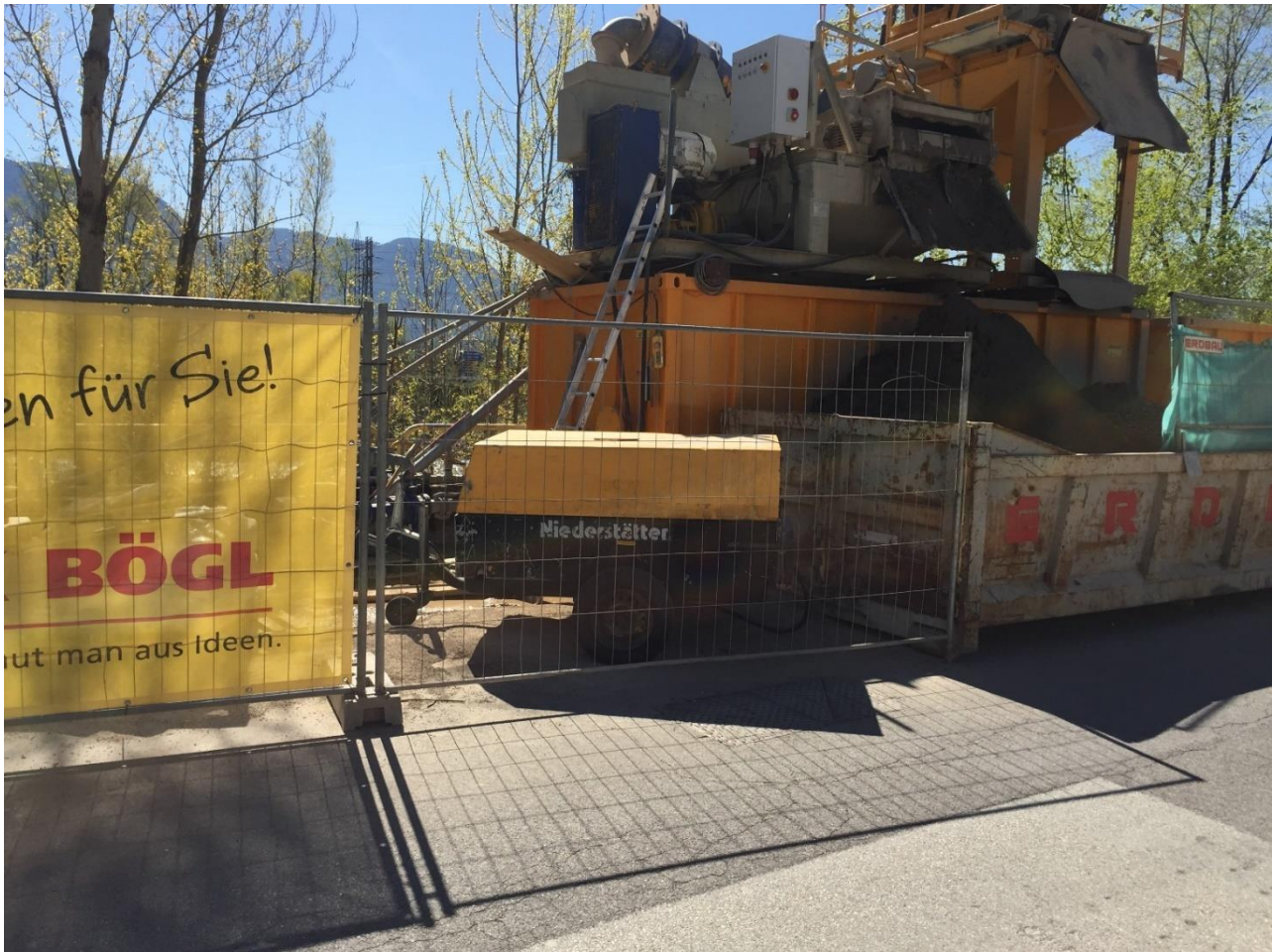
Figura 9-G : Cantiere microtunnelling pozzo di spinta
