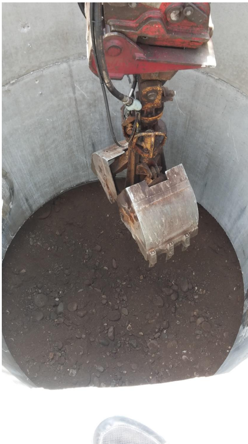
Figura 8-H : Scavo con rostro interno pozzo autoaffondante
