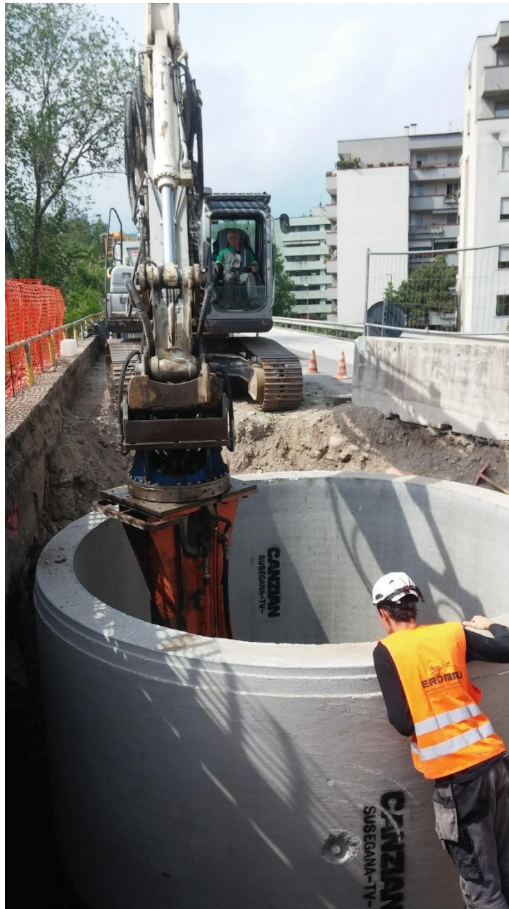
Figura 8-I : Scavo con rostro interno pozzo autoaffondante
